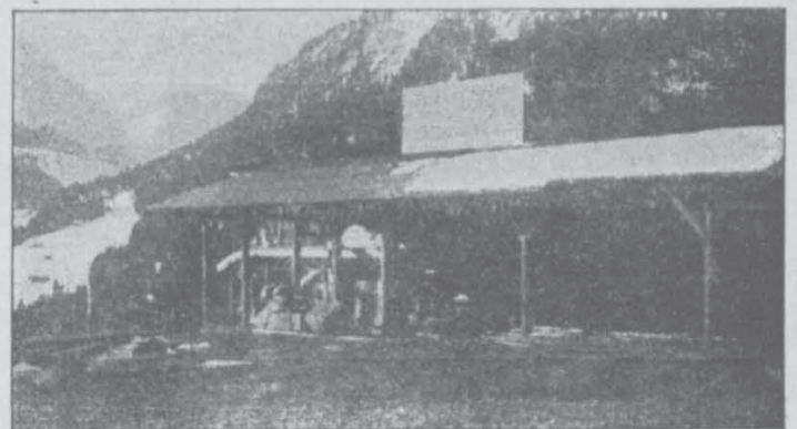
Fig. 28. Obere Bremsbergstation (Annahme auf der Poststraße).
